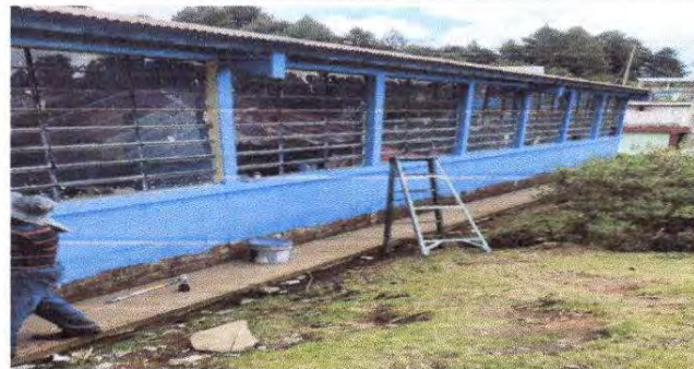
FOTO 6: Pintando muro exterior 28 mts largo y 2.5 de alto
