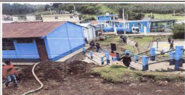
FOTO 13: extracción de desechos de fosa septica
