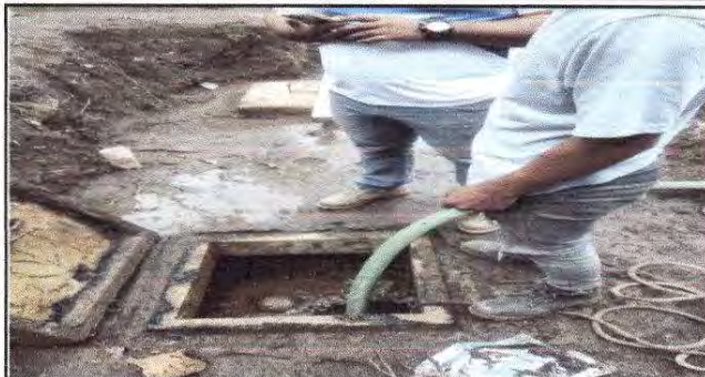
FOTO 14: extracción de desechos de fosa septica
