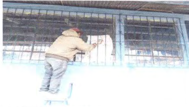
FOTO 10: Mantenimiento de barandas
