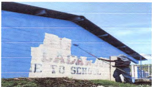
FOTO 7: Pintando muro exterior 28 de largo 2.5 de alto
