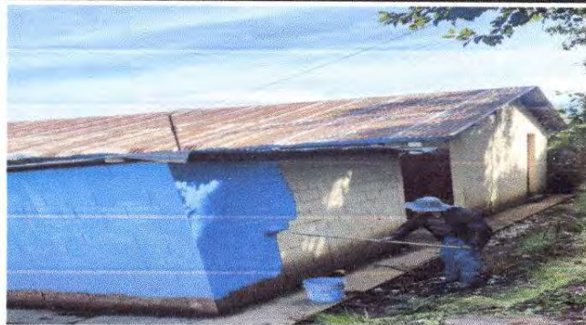
FOTO 8: Pintando bodega y muro exterior de escuela
