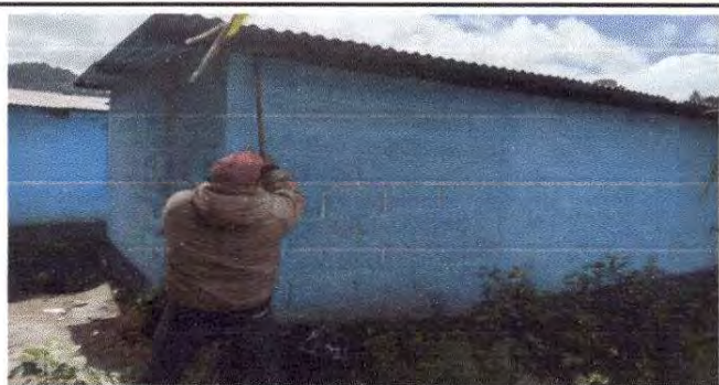
FOTO 11: Pintando exterior de la cocina
